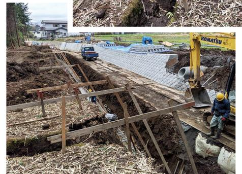
かじか沢川の護岸工事と台風19号で崩落した農業水路の法面復旧工事を県土木御殿場支所に働き掛け、復旧工事を実現しました。
